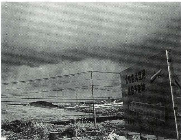
平成10年開港にむけての大規模な工事が進んでいます
