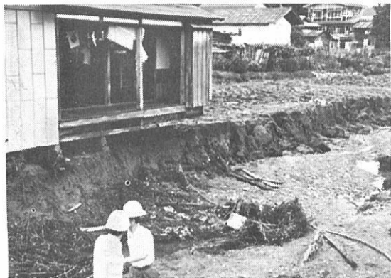
本城寺ノ沢川堤防決壊によりあわや流失寸前
