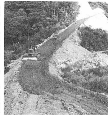
急ピッチで進められている現場
