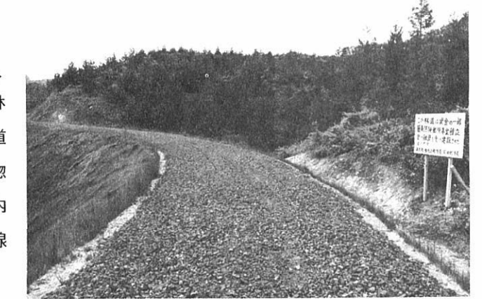
林道惣内線 林道浦支内支線2
