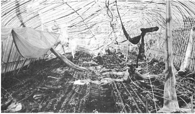
▶ 全町のビニールハウスはほとんどが全壊
