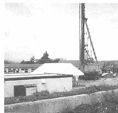
建設中の新しい米内沢保育園
