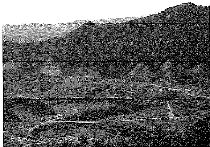
向様田地区周辺の迂回路工事状況
