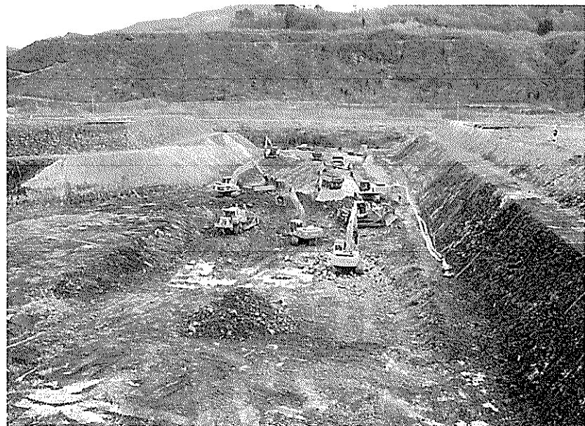
仮排水トンネル呑口部の水路掘削
