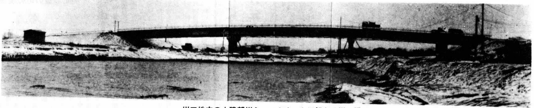
川口地内の小猿部川ショートカットに架かる川口橋
