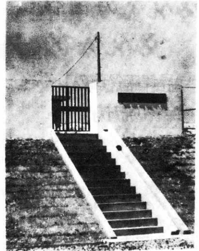
▲陳場岱の高台にある配水池（常時2千トンの水がたくわえられております）＝ここから各家庭に給水されます
