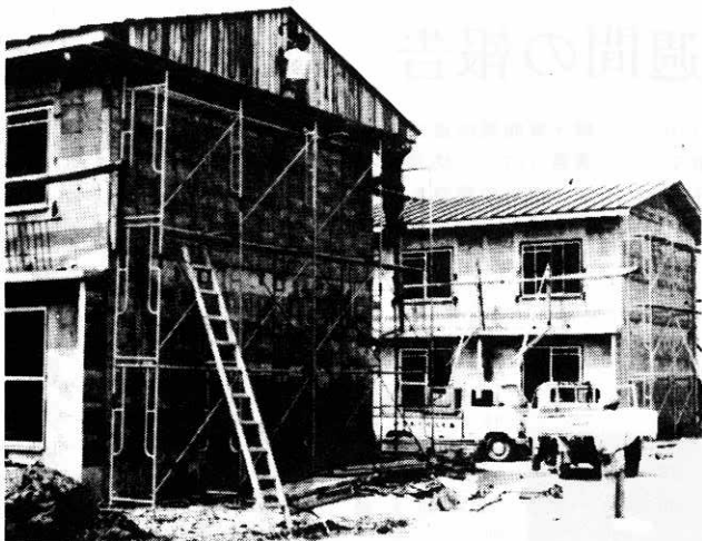
▲南鷹巣団地に建築中の町営住宅
