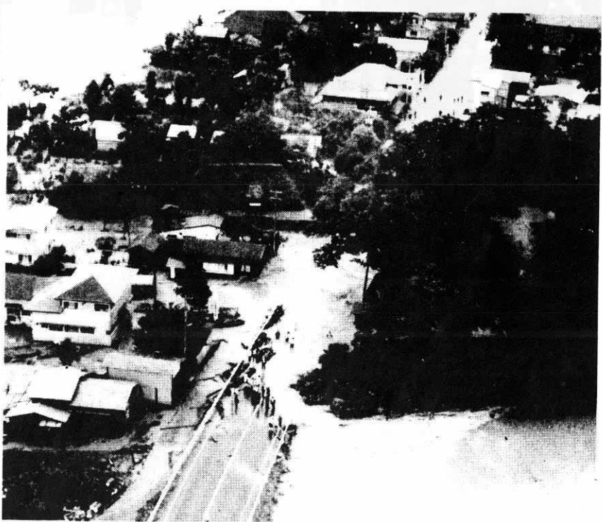
▲国道105号線小猿部橋（七日市地内）200メートル上流の堤防が欠壊、またたくまに激流が七日市部落に入り込む。（自衛隊第6師団ヘリから—自衛隊提供）
