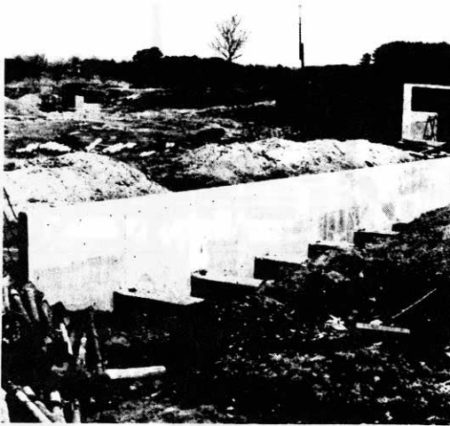
▲中央公園下に工事中の町民球場
