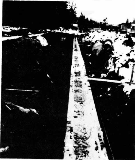
▶急ピッチで工事がすすむ造成団地
