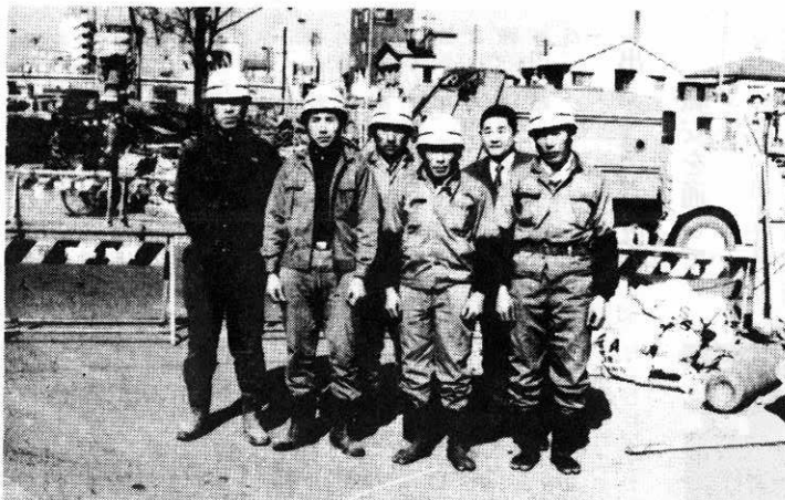
▲高速道路工事の、鉄筋作業に働く坊沢のみなさん。
