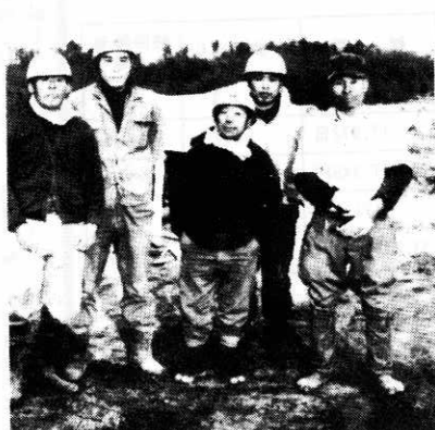
▼山下組（神奈川県藤沢市）＝四名 宅地造成の下水道工事に働いていました
