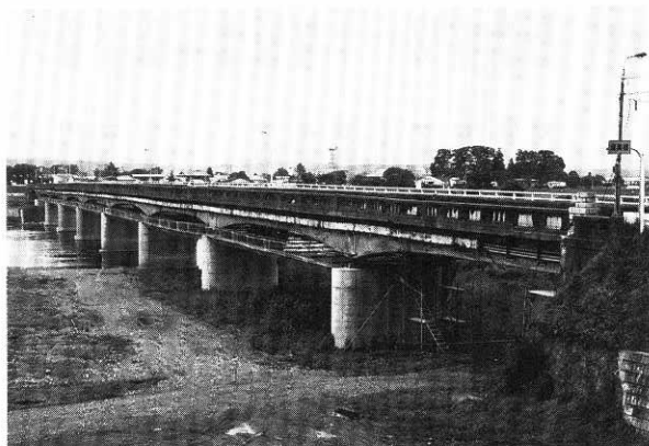
面目が一新される「鷹巣橋」
