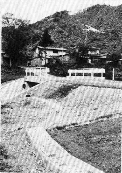
与助岱地内の「片逸沢橋」
