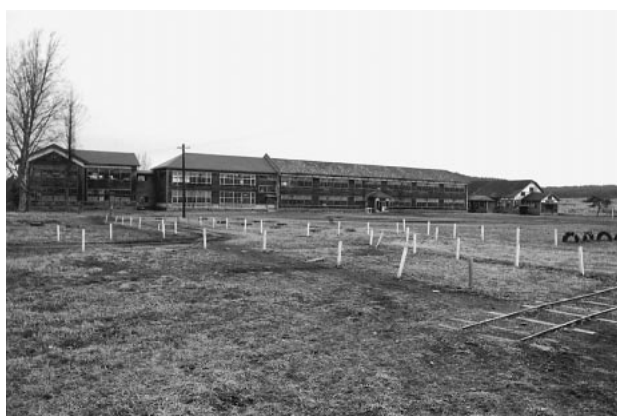
▲解体前の沢口小学校。昭和4年、脇神から移転、高森塚ノ岱（現小摩当集落）に建設された。
