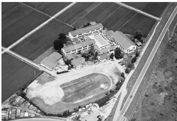
▲昭和30年に栄小中学校として建設された旧校舎。昭和3年にできたこの前の校舎も古川布にあった。
