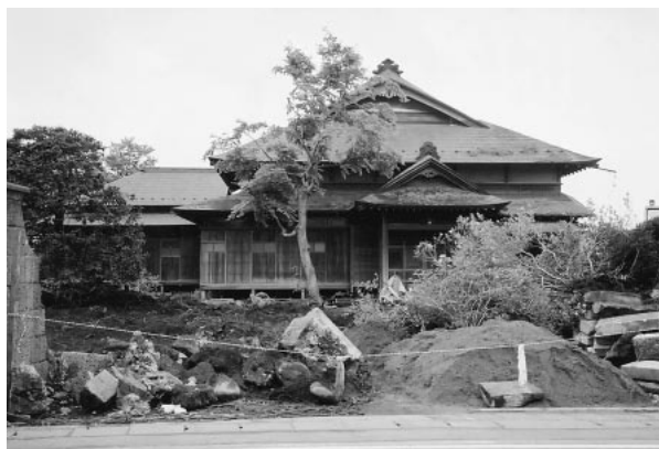
▲解体が始まった頃の元町・相馬邸
