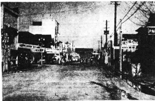
【舗装成った米代町通り】
