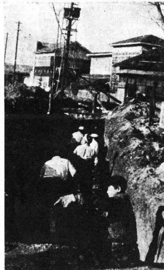
【簡易下水工事現場】
