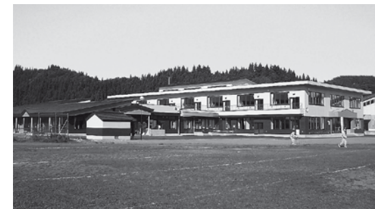
▲前田小学校、前田保育園竣工(H18.10.14)
